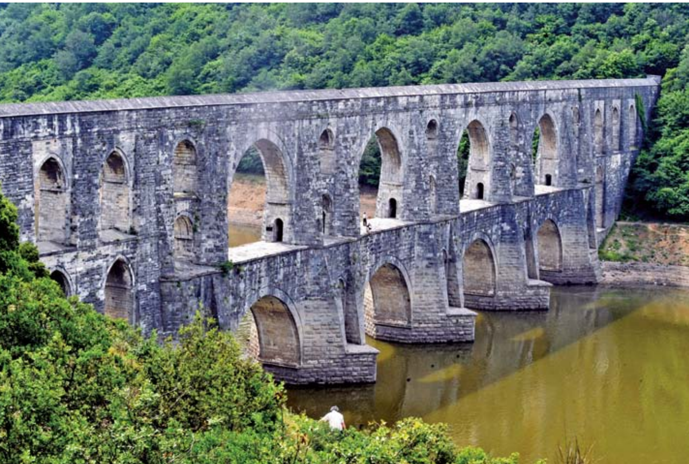
16世紀、イスタンブールにつくられたスィナン設計の上水道
